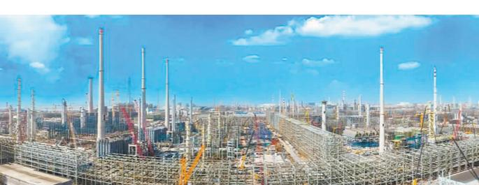
盛虹炼化1600万吨/年一体化项目建设规模为1600万吨/年炼油、280万吨/年芳烃、110万吨/年乙烯及其他下游产品，并配套30万吨原油码头、300万立方米仓储及公用工程岛项目，总投资约677亿元。
